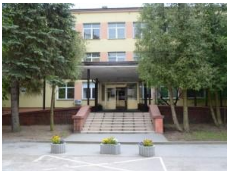
Budynek Samodzielnego Publicznego Zakładu opieki Zdrowotnej w Mławie
