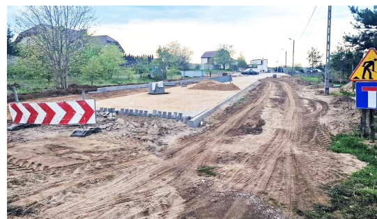
Ulica 20 Dywizji Piechoty Wojska Polskiego jest w trakcie remontu
