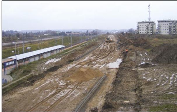
Trwają prace przy budowie Alei Św. Wojciecha
