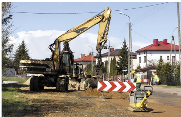
Część środków przeznaczono na inwestycje związane z budową kanalizacji sanitarnej
