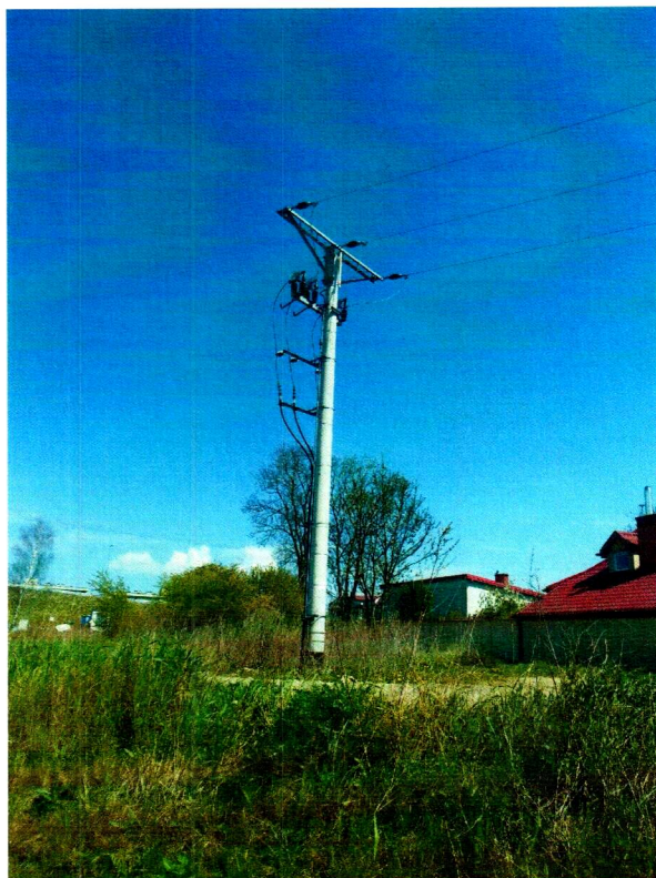
Zdj. 1 - Istniejący odłącznik O6-3246 (słup nr 48 typu Kgo 12/17,5E) do przestawienia
