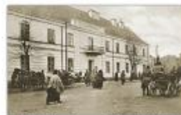
Budynek na Starym Ryнку w Mławie, siedziba rosyjskiego Zarządu Powiatowego w Mławie, a po zajęciu Mławy przez Niemców niemiecka poczta polowa
