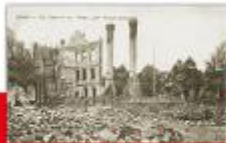
Ruiny hotelu „Zum Forsten Bismarck” w Iławie w Prusach Wschodnich
