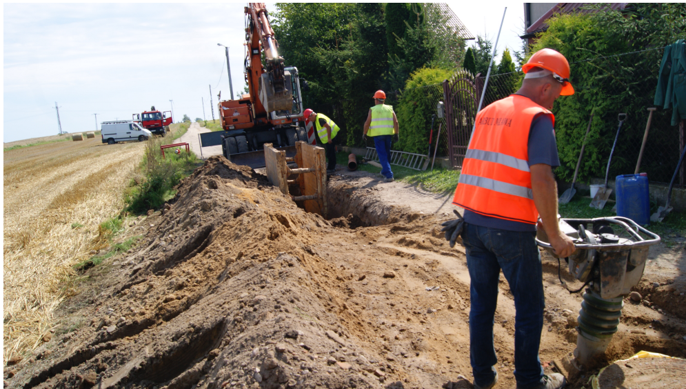
Roboty budowlane w ulicy Piaskowej
