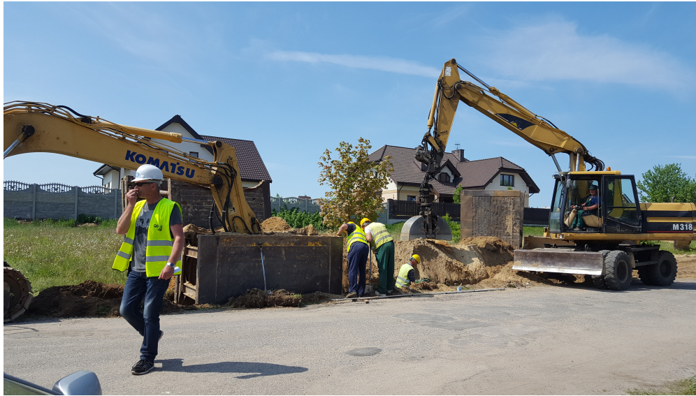
Roboty budowlane w ulicy 20 Dywizji Piechoty WP
