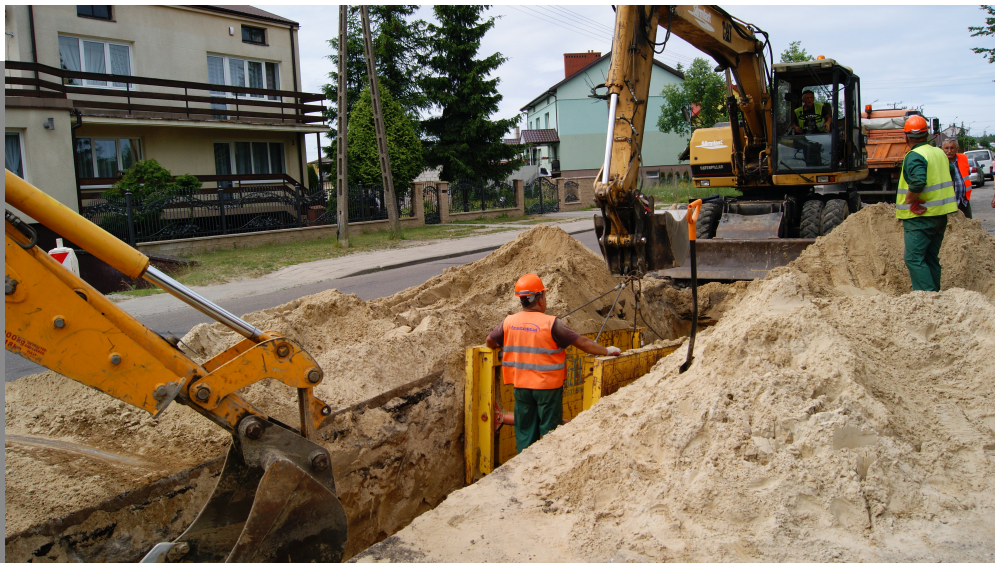
Roboty budowlane w ulicy Nowej
