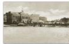
Bawarski szpital polowy w Miławie. Przed nim kotłownia sanitarna
