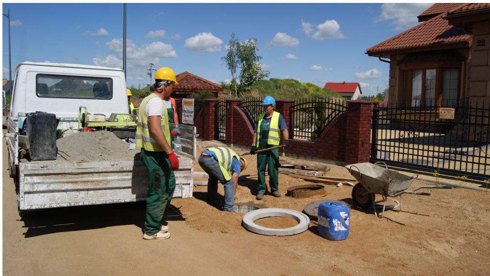
Roboty budowlane w ulicy Kryszkiewicza
