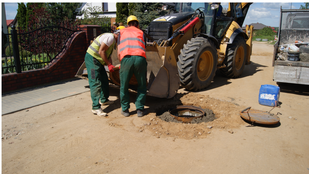
Montaż wjazdu w ulicy Kryszkiewicza
