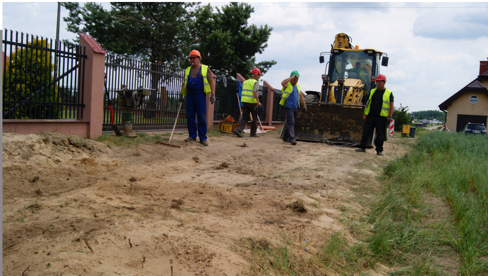
Roboty budowlane w ulicy Poziomkowej
