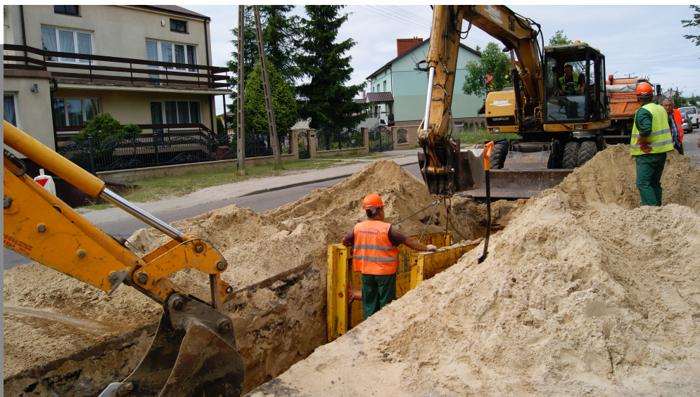
Roboty budowlane w ulicy Nowej
