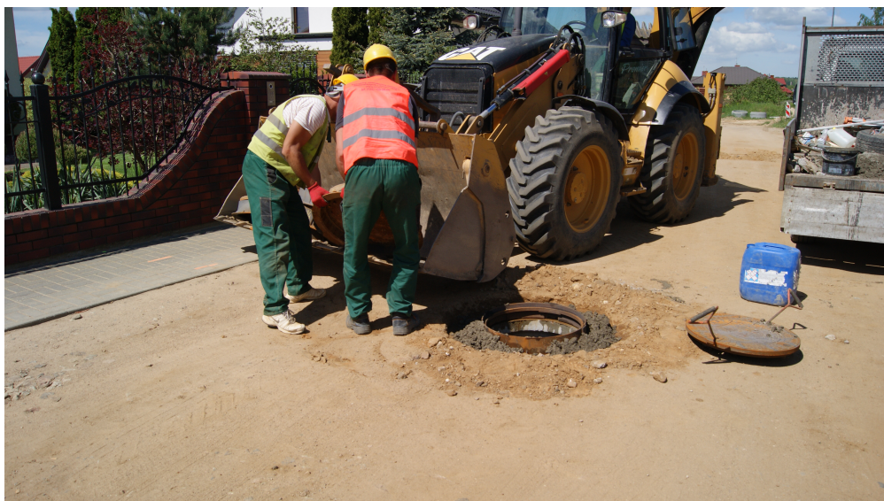
Montaż wjazdu w ulicy Kryszkiewicza
