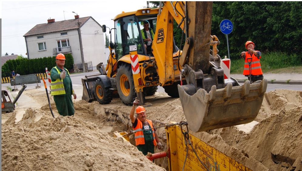
Roboty budowlane w ulicy Nowej
